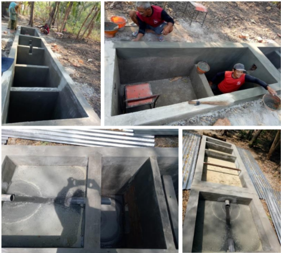
Gambar 4.4. Konstruksi IPAL UMKM Batik Sariwarni
